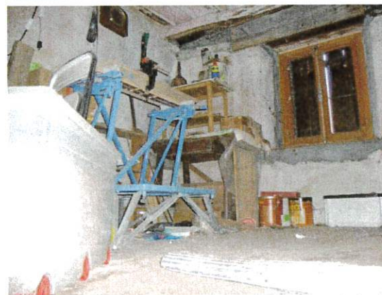
remise – au-dessus de la salle de bain
